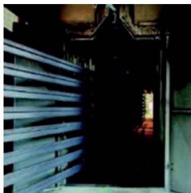
Einfahren in den Einbrennofen Feeding the stove furnace
